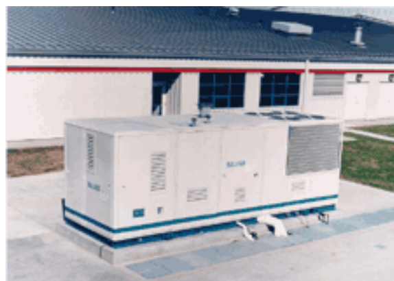
Rys. 6. Genrator z rys. 5 w Cinergy USA.
